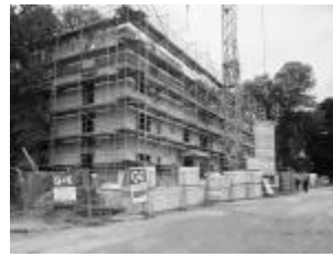
Die Baustelle im Elfriede-Lohse-Wächter Weg.
